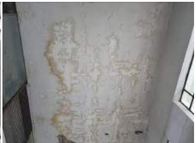
Aspectos da infiltração que consta no teto e da exposição de armadura de aço oxidada
